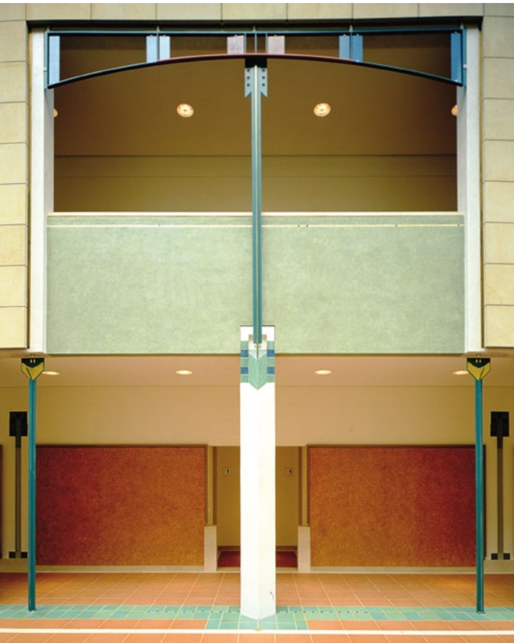
Detail der Innenfassade in der zentralen Halle
